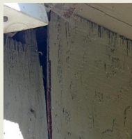
Sellando el revestimiento agrietado
